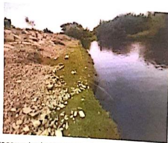
Foto N°12: Uña antizocavante de enrocado de protección expuesto, Aguas Arriba de la Bocatoma Ucupe – Mocupe
