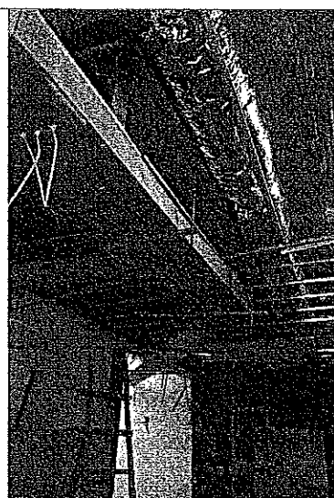
Bandeja Portacable Existente (Retiro)
