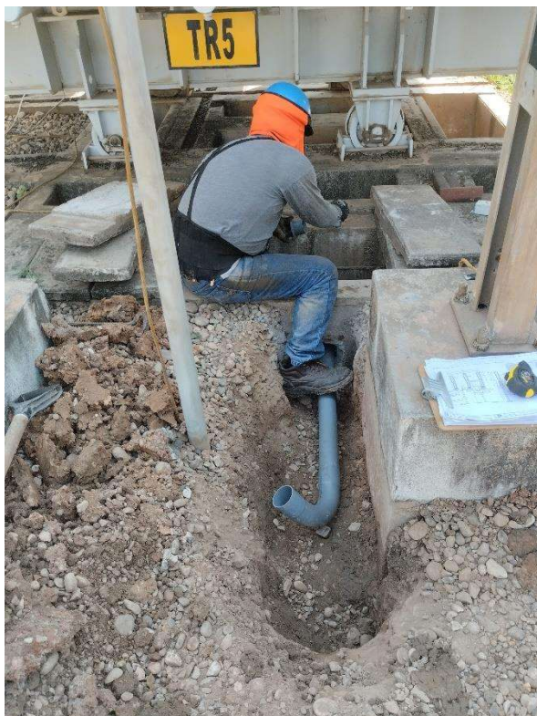
MONTAJE DE TUBERIA SAP 3" PARA CABLES DE CONTROL
