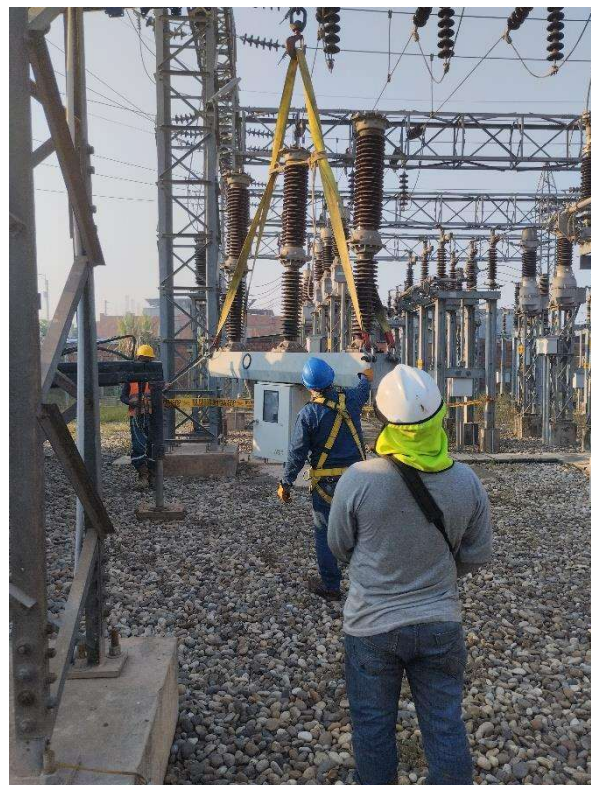
RETIRO DE INTERRUPTOR EXISTENTE 60KV
