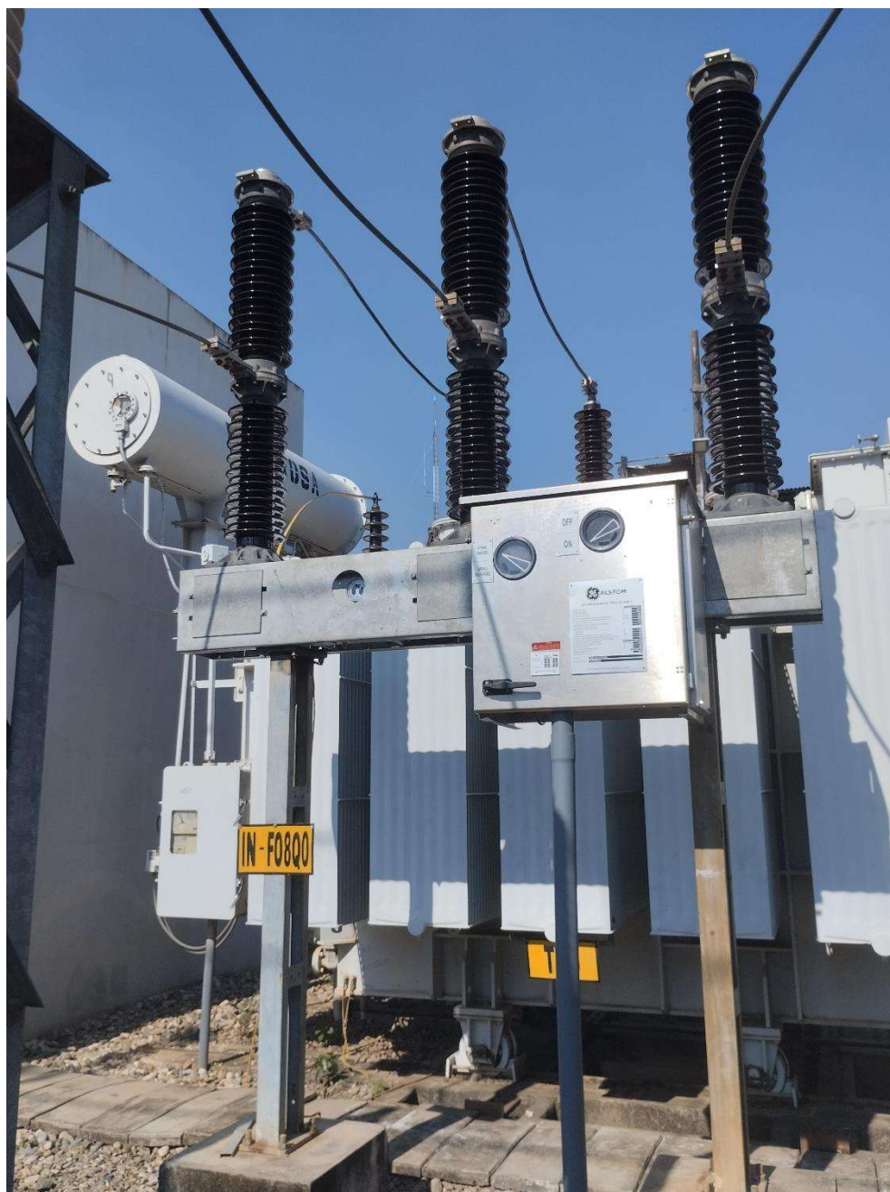
CULMINACION DE MONTAJE DE NUEVO INTERRUPTOR 60KV
