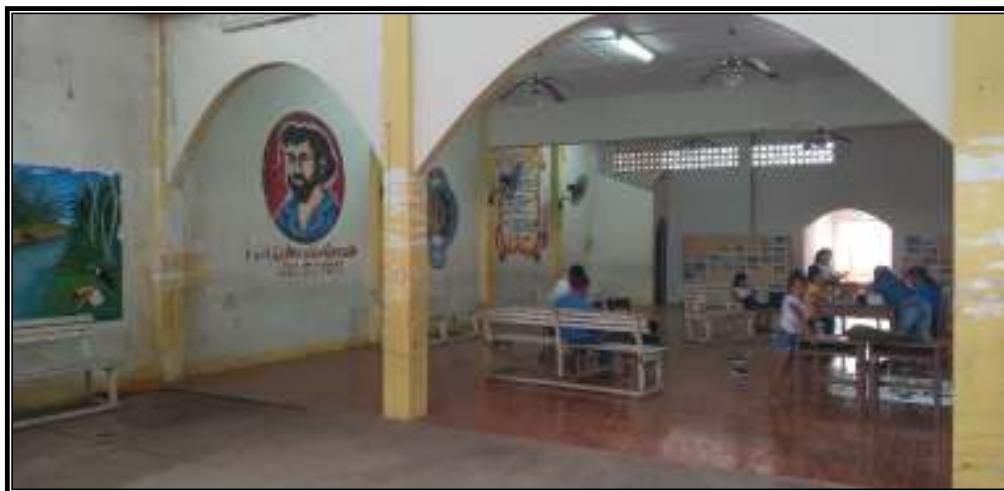
SE APRECIA EL PISO A MEDIO TERMINAR EN SU ENCHAPADO
