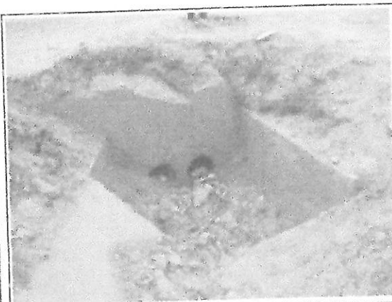
Foto 04: Ingreso de alcantarilla de desfogue en inicio de tramo, dos tuberías Ø 8" cada una. Cabezal de ingreso en malas condiciones y obstruido.
