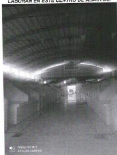
IMAGEN N° 05: EXISTE UNA ZONA DEL MERCADO QUE ESTA DESTINADA PARA LA VENTA DE CARNES Y PESCADOS, LA CUAL FUE CONSTRUIDA EN EL AÑO 2019, ESTA INFRAESTRUCTURA PRESENTA BUEN ESTADO DE CONSERVACION, CUENTA CON ESTANDS DE MATERIAL NOBLE REVESTIDOS CON CERAMICA, ASI COMO COBERTURA METALICA CON CALAMINON, ESPACIOS DE CIRCULACION INTERNA QUE PERMITEN EL LIBRE TRANSITO PEATONAL.
