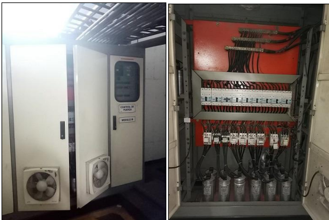
Banco de condensadores, modulo "B" De compensación automática.
