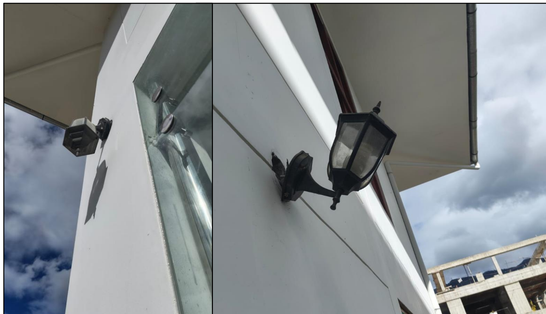
Imagen N°12: vista de los aparatos eléctricos defectuosos, desprendiéndose de la pared.
