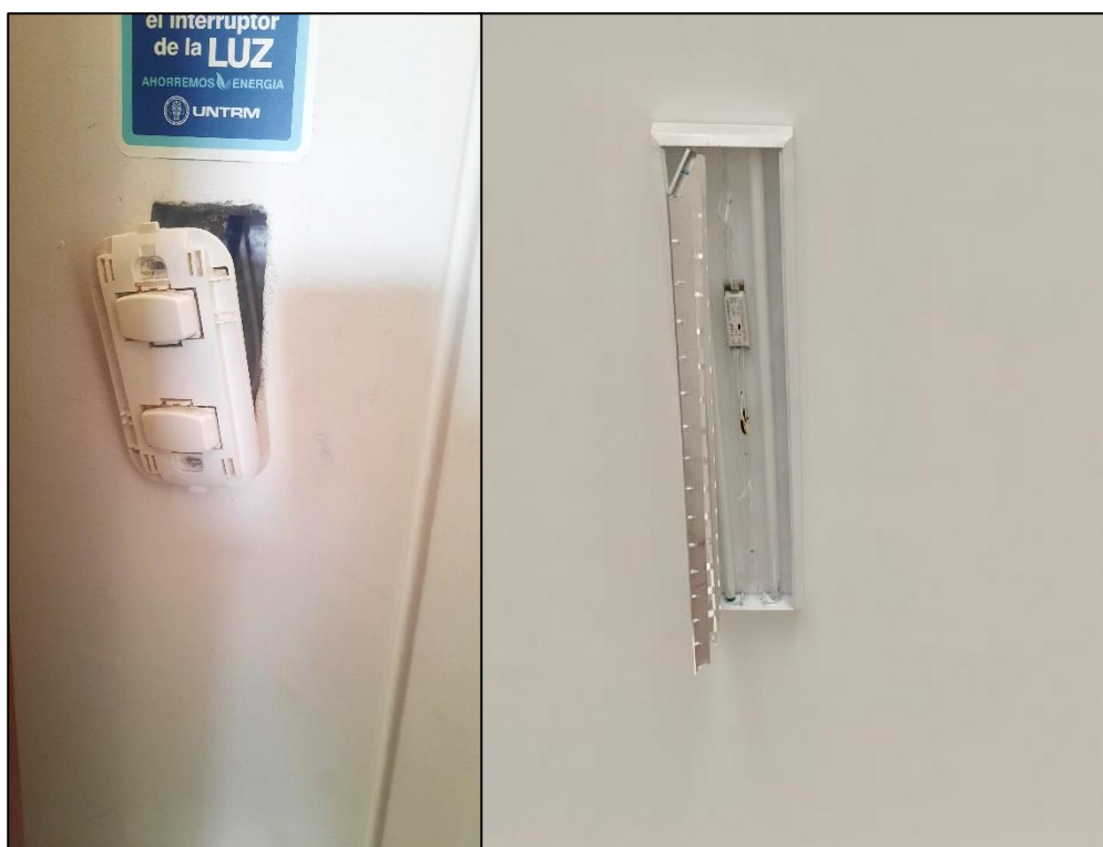
Imagen N°11: vista de los aparatos eléctricos defectuosos, desprendiéndose de la pared y cielo raso.
