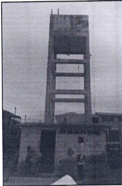
Fotografía N°04: TANQUE ELEVADO EXISTENTE SE ENCUENTRA AL INTERIOR DEL INSTITUTO Y ESTÁ DETERIORADO E INOPERATIVO
