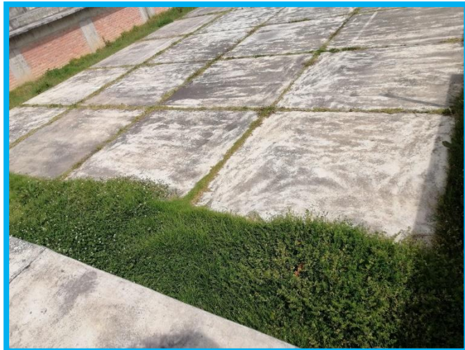
Fotografía 04. Se puede observar la vegetación que está comenzando a crecer por las partes que falta concretar la losa y por falta de sellado de las juntas en la losa existente, para ello se debe implementar estas necesidades para así evitar daños estructurales próximos.
