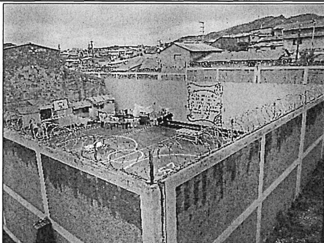
Vista de patio con concertinas deformes y módulos de sshh sin concertinas
