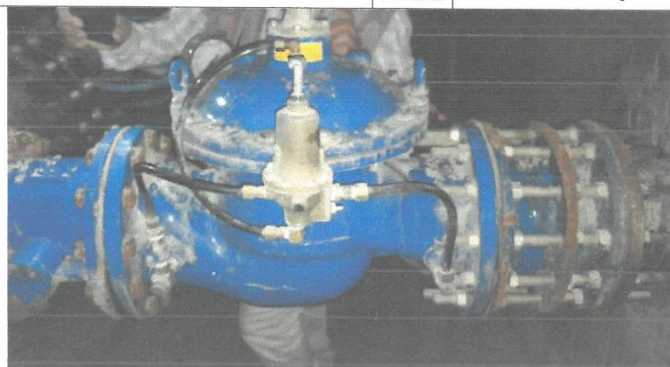
Fig N°21 Situación actual de válvulas reductora de presión, manómetros en CD: 02
