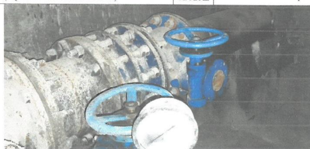
Fig N°19 Situación actual manómetros y válvula compuerta mariposa en CRP: 03-ADUCCIÓN
