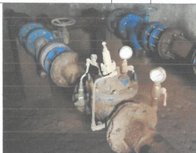
Fig N°14 Situación actual de válvulas reductora de presión, manómetros y válvula compuerta tipo mariposa en CRP: 14
