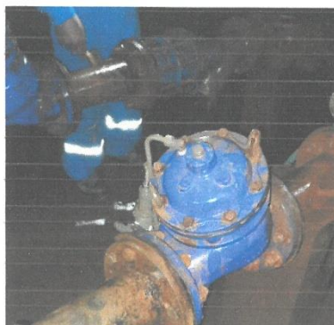
Fig N°10 Situación actual de válvulas reductora de presión, manómetros y compuerta mariposa en CRP: 10
