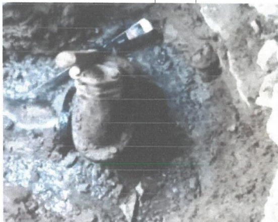
Fig N°17 Situación actual de válvula compuerta f.f. bb. de 200mm en RESV: 01
