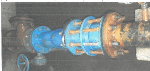
Fig N°17 Situación actual de válvulas reductora de presión, manómetros y compuerta mariposa en CRP: 01-ADUCCIÓN
