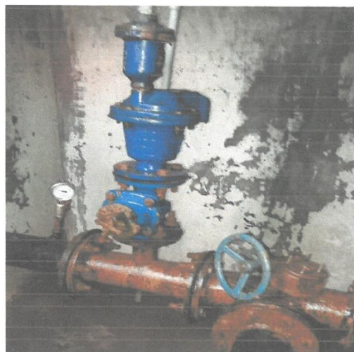
Fig N°4 Situación actual de válvulas de aire y compuerta mariposa en CRP: 04
