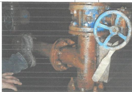
Fig N°11 Situación actual de válvulas compuerta mariposa en CRP: 11
