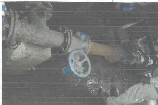
Fig N°13 Situación actual de válvulas reductora de presión, manómetros y válvula compuerta tipo mariposa en CRP: 13
