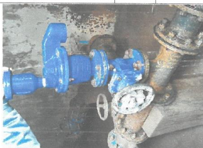
Fig N°15 Situación actual de válvulas reductora de presión, válvula compuerta tipo mariposa y aire en CRP: 15
