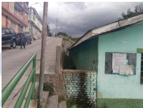
FOTOGRAFÍA 03: NO EXISTE CANALETAS PARA EVACUAR LAS AGUAS DE LLUVIA
