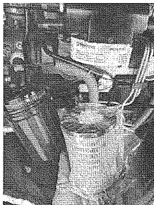
Limpieza de avr, generador y megado del generador
