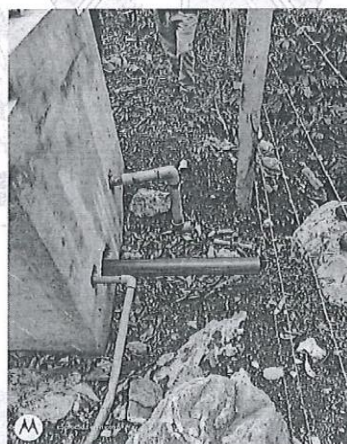
FOTO N° 29: Tubería descubierta desde el reservorio en el caserío La Hacienda.
