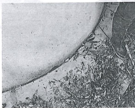
FOTO N° 08: Abertura entre las veredas y reservorios, ocasionando humedad en la cimentación de reservorios.
