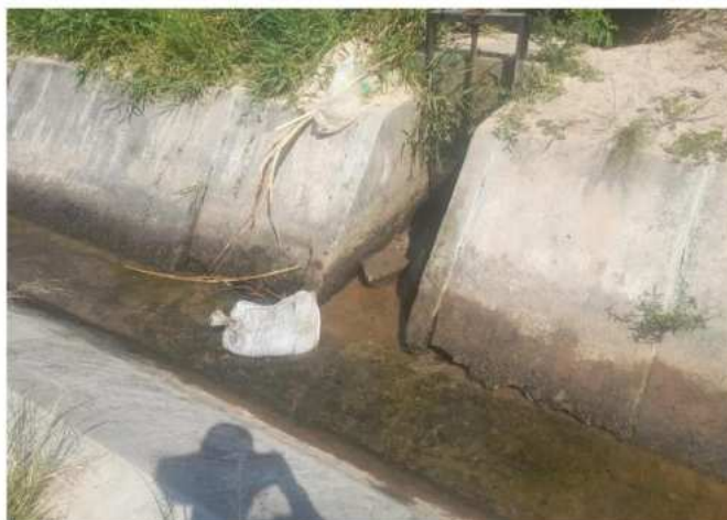
Foto: Progresiva 1+437, muros laterales deteriorados, con filtración de agua a talud de relleno.
