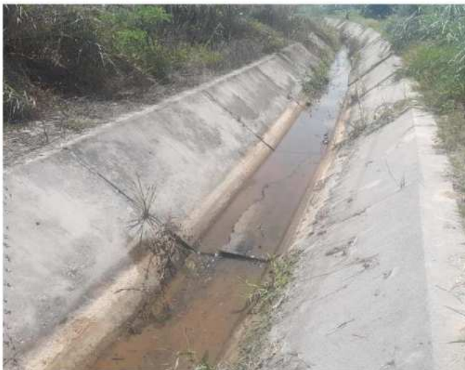
Foto: Asentamiento Progresiva 3+030
