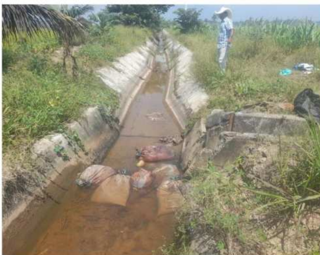
Foto: Progresiva 2+218, muros laterales deteriorados, con filtración de agua a talud de relleno.
