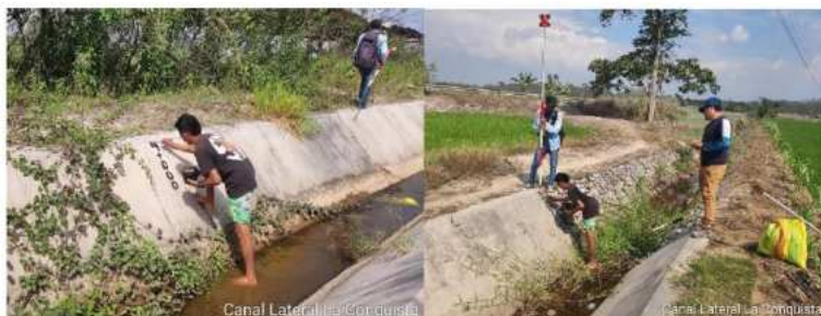
Foto: Marcado de Progresivas para identificación e inventario
