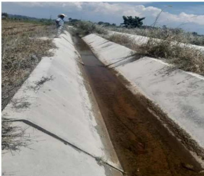
Foto: Asentamiento Progresiva 3+000
