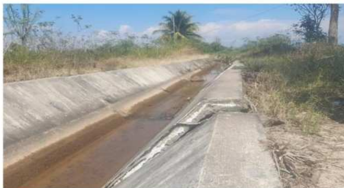
Foto: Asentamiento Progresiva 1+780
