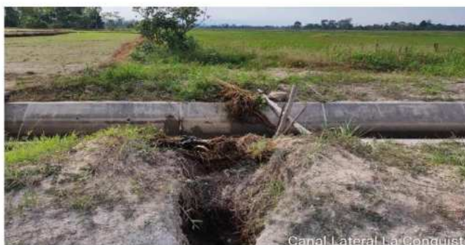
Foto: Asentamiento Progresiva 0+114
