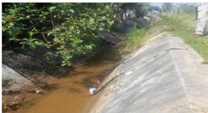
Foto: Empuje y rotura Progresiva 1+980
