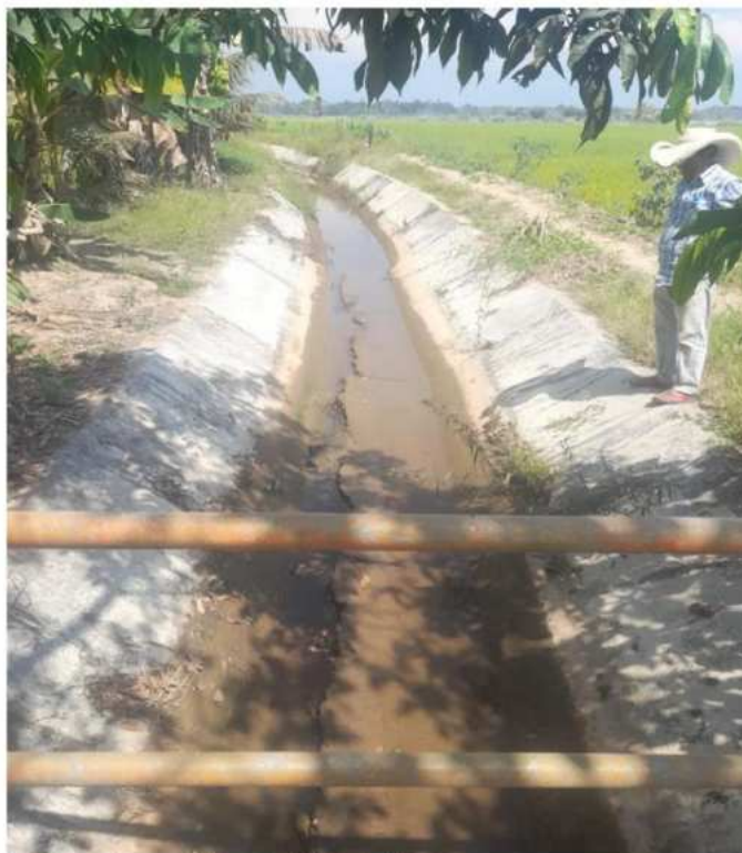
Foto: Asentamiento y rotura Progresiva 2+120 – 2+140
