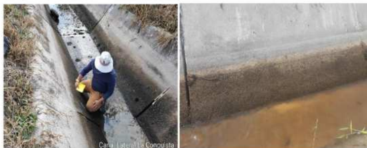
Foto: Juntas Elastómeras deterioradas e inexistentes
