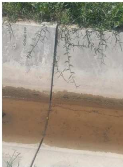
Foto: Juntas Elastómeras inexistentes
