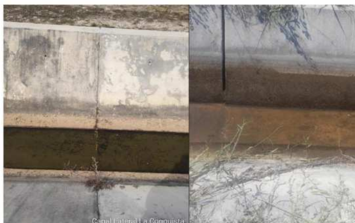
Foto: Juntas Elastómeras deterioradas e inexistentes
