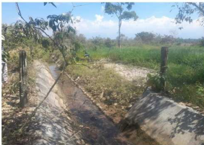
Foto: Progresiva 3+604 BB03, no se visualiza presencia de ganadería, estado abandono, maleza.
