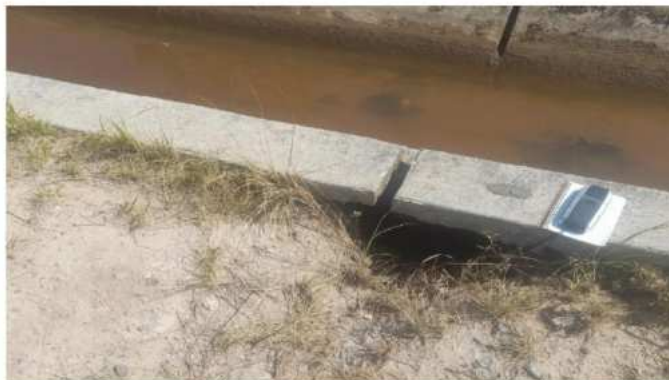
Foto: Asentamiento Progresiva +1+580
