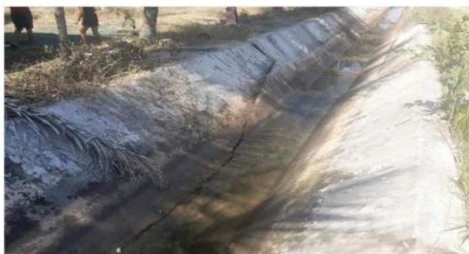
Foto: Empuje y rotura Progresiva 2+000
