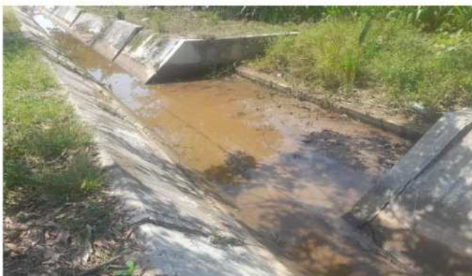
Foto: Asentamiento Progresiva 2+120
