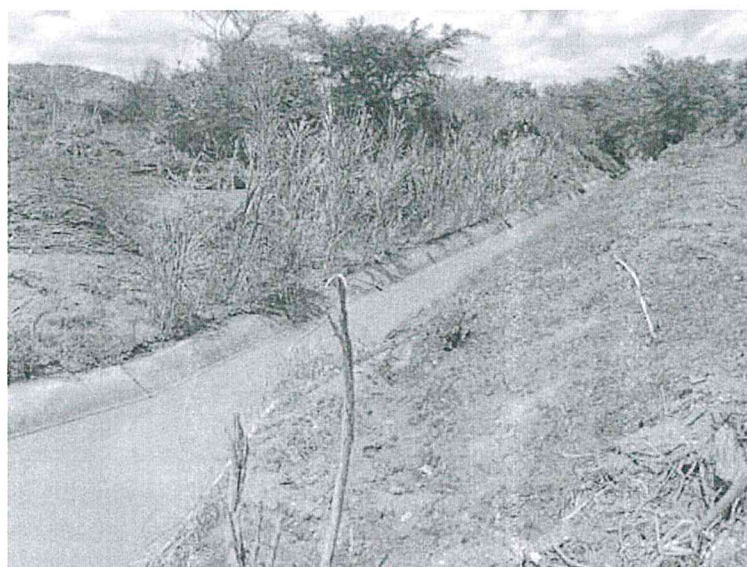
Presencia de sedimentos en la sección del canal del Rio Zaña
