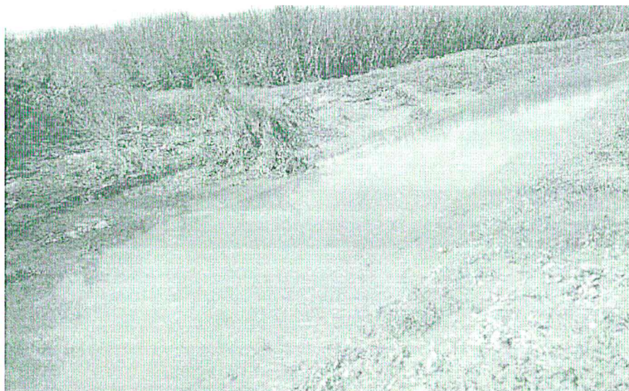
Material solido acumulado en el cauce del Canal Collique Bajo - Popan
