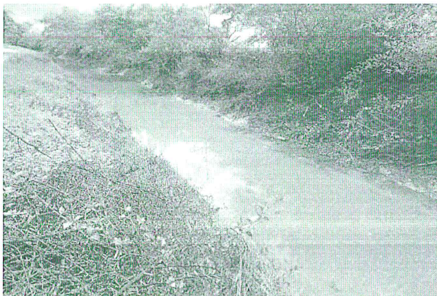
Tramo crítico colmatado del Canal Collique Bajo - Popan – Zaña
