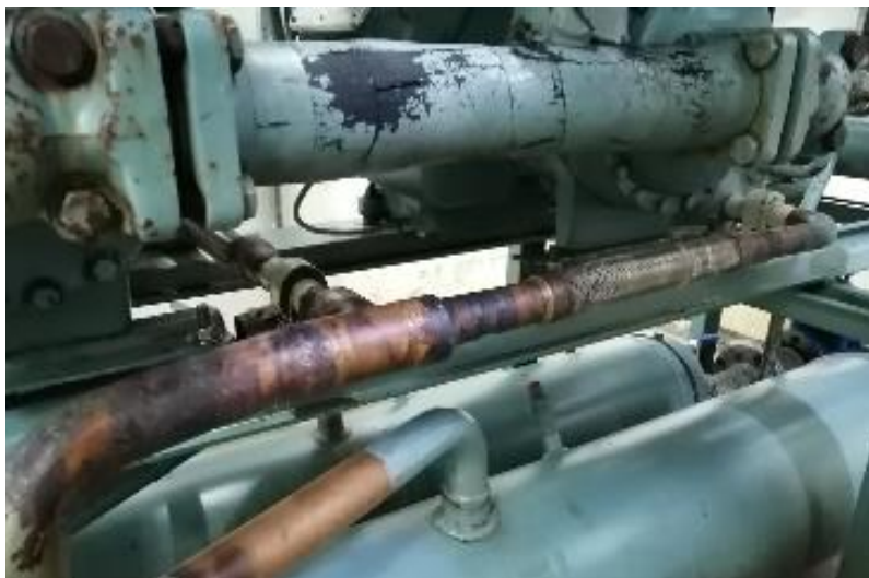
Fig. 05. Anti vibrador circuito 1 – compresor 1.
