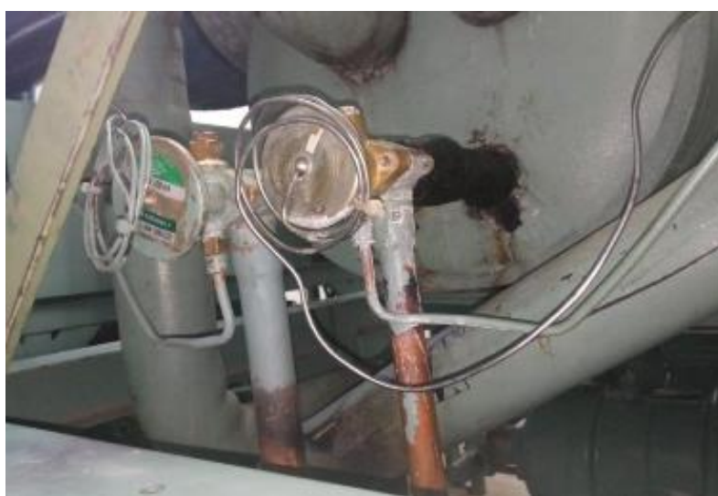
Fig. 04. Válvulas de expansión circuito 1 y 2.
