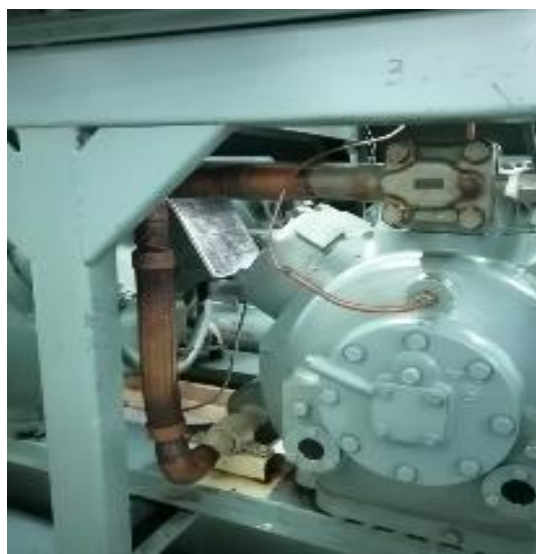
Fig. 07. Anti vibrador circuito 2 – compresor 1.
