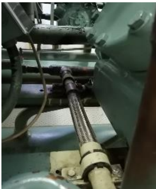
Fig. 06. Anti vibrador circuito 1 – compresor 2.
