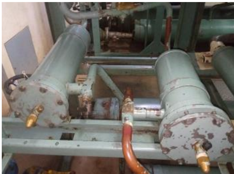
Fig. 08. Filtros de circuito 1 y 2.
