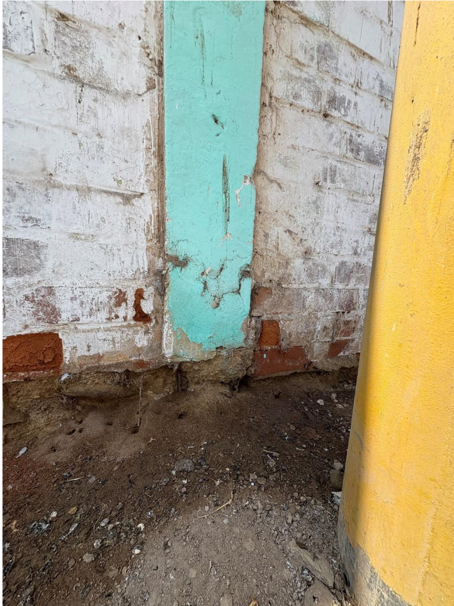
Imagen N°06: Cerco Perimétrico Vista Interior: 1er. tramo de cerco perimétrico en riesgo de colapso: Las columnas no tienen peralte que ofrezca resistencia al volteo, el acero de las columnas a la altura del sobrecimiento se encuentra expuesto y mal estado.
