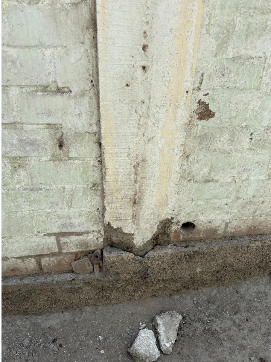
Imagen N°08: Cerco Perimétrico Vista Interior: 1er. tramo de cerco perimétrico en riesgo de colapso: Las columnas no tienen peralte que ofrezca resistencia al volteo, el acero de las columnas a la altura del sobrecimiento se encuentra expuesto y mal estado
