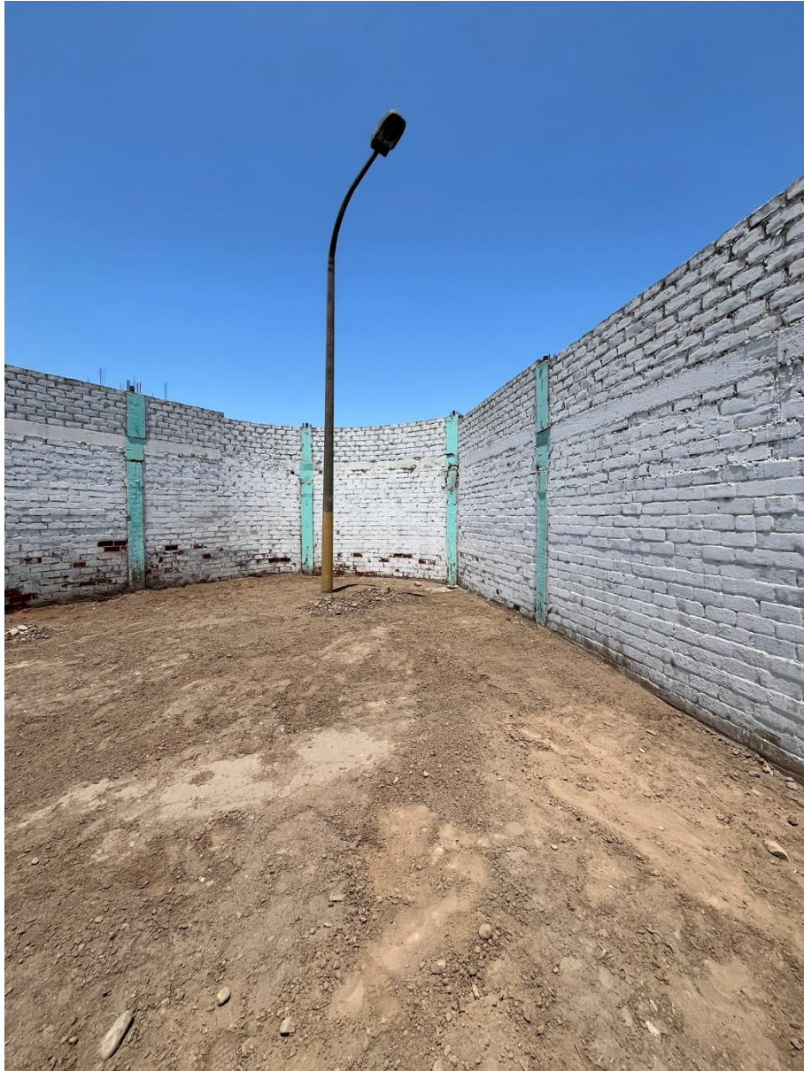
Imagen N°10: Cerco Perimétrico Vista Interior: 1er. tramo de cerco perimétrico en riesgo de colapso: Las columnas no tienen peralte que ofrezca resistencia al volteo, el acero de las columnas a la altura del sobrecimiento se encuentra expuesto y mal estado.
