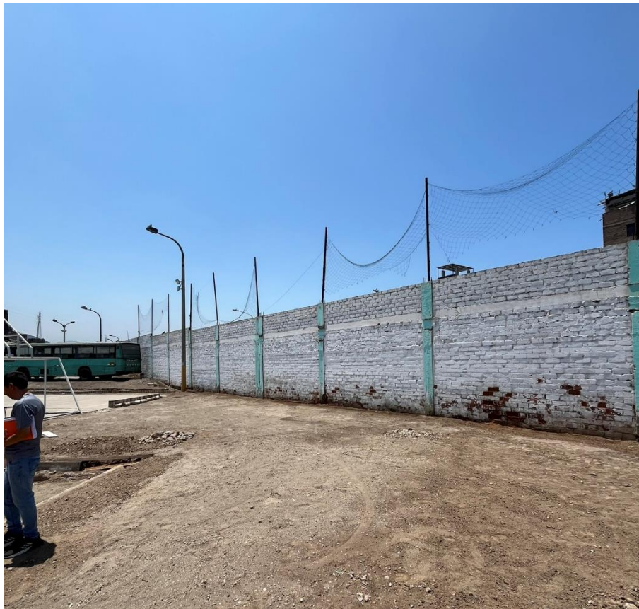
Imagen N°05: Cerco Perimétrico Vista Interior: 1er. tramo de cerco perimétrico en riesgo de colapso.
