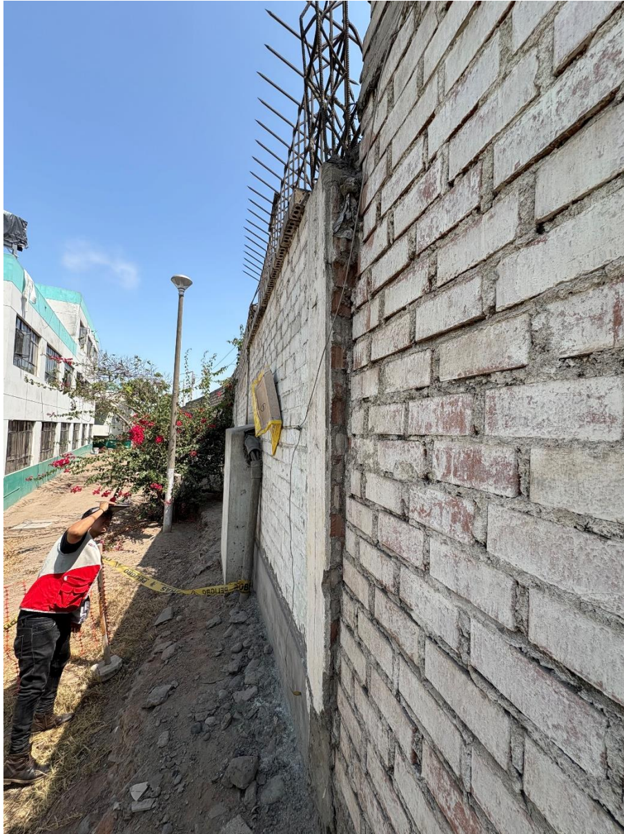
Imagen N°11: Cerco Perimétrico Vista Interior: 2do. tramo de cerco perimétrico en riesgo de colapso: Las columnas no tienen peralte que ofrezca resistencia al volteo, el acero de las columnas a la altura del sobrecimiento se encuentra expuesto y mal estado. Asimismo, el muro en algunas zonas ya se encuentra inclinado.
