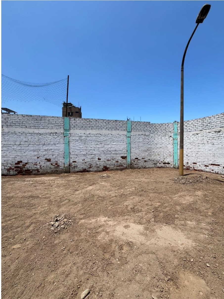
Imagen N°09: Cerco Perimétrico Vista Interior: 1er. tramo de cerco perimétrico en riesgo de colapso: Las columnas no tienen peralte que ofrezca resistencia al volteo, el acero de las columnas a la altura del sobrecimiento se encuentra expuesto y mal estado
