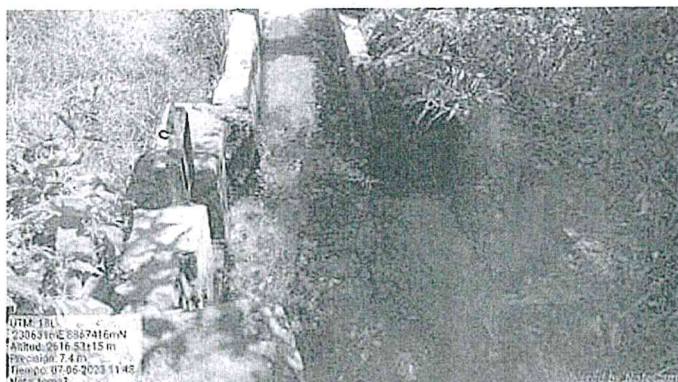
Foto N°02. Se verifico la ubicación de una Toma Lateral, y se puede observar el canal de concreto existente.
