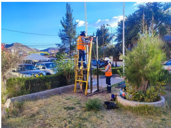
Foto 89: Ejecución de trabajos Sondeo S-5.
