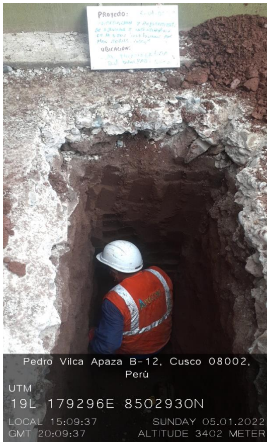
FOTO N°2.- Excavación de la calicata c-01
