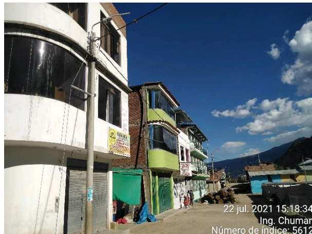
Retenidas sin aislar, postes cerca de fachada de viviendas en San Sebastian de Sacaca.
