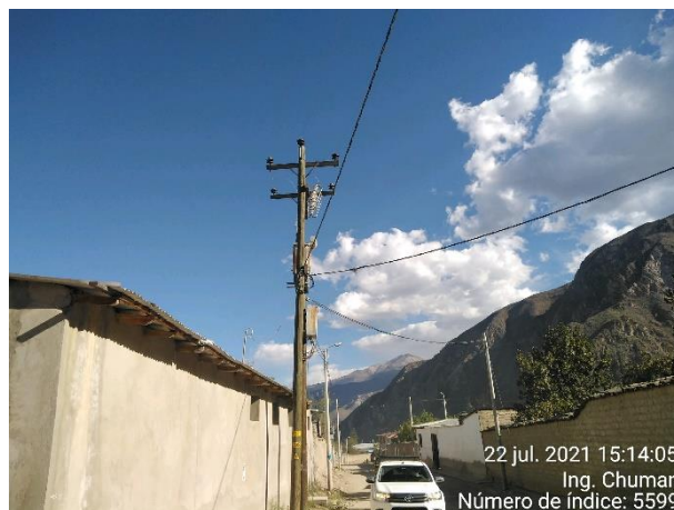
Subestación trifásica en San Sebastian de Sacaca incumple DMS respecto a viviendas por disposición horizontal de conductores.
