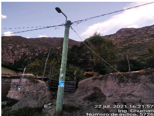
Retenidas sin aislar en redes secundarias en Nahuapampa
