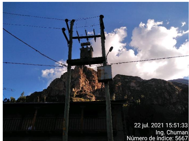
SED de 40 kVA en la localidad de Colcabamba.
