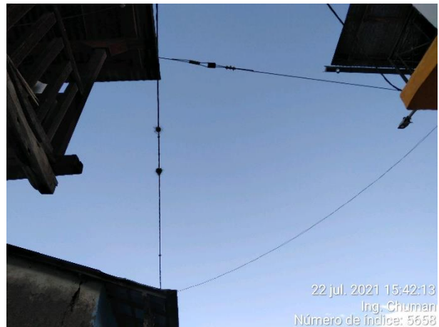
Retenidas aéreas en cruce con conductor autoportante en Lampa
