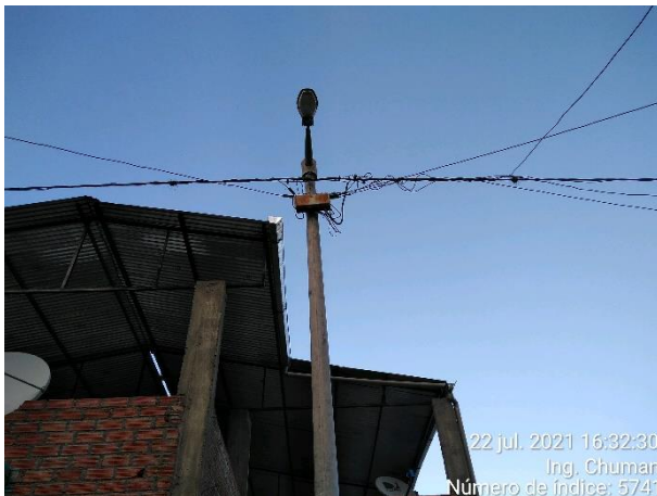
Cajas de derivación en mal estado de conservación
