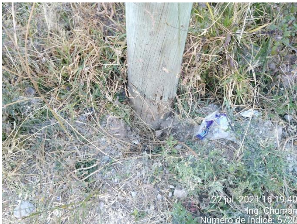
Base de postes de eucalipto de baja tensión en mal estado de conservación en Nahuapampa
