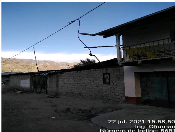
Acometidas Trifásicas en mal estado de conservación en Colcabamba
