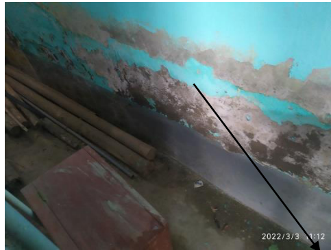
Fotografía 02: Se muestra la humedad existente en muros de la institución de la Institución Educativa, no presenta fallas estructurales.
