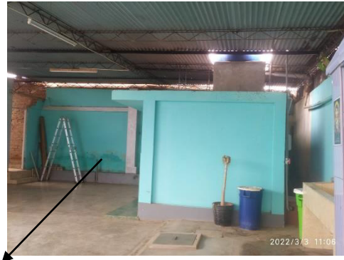
Fotografía 02: Se muestra la humedad existente en muros de la institución de la Institución Educativa, no presenta fallas estructurales.
