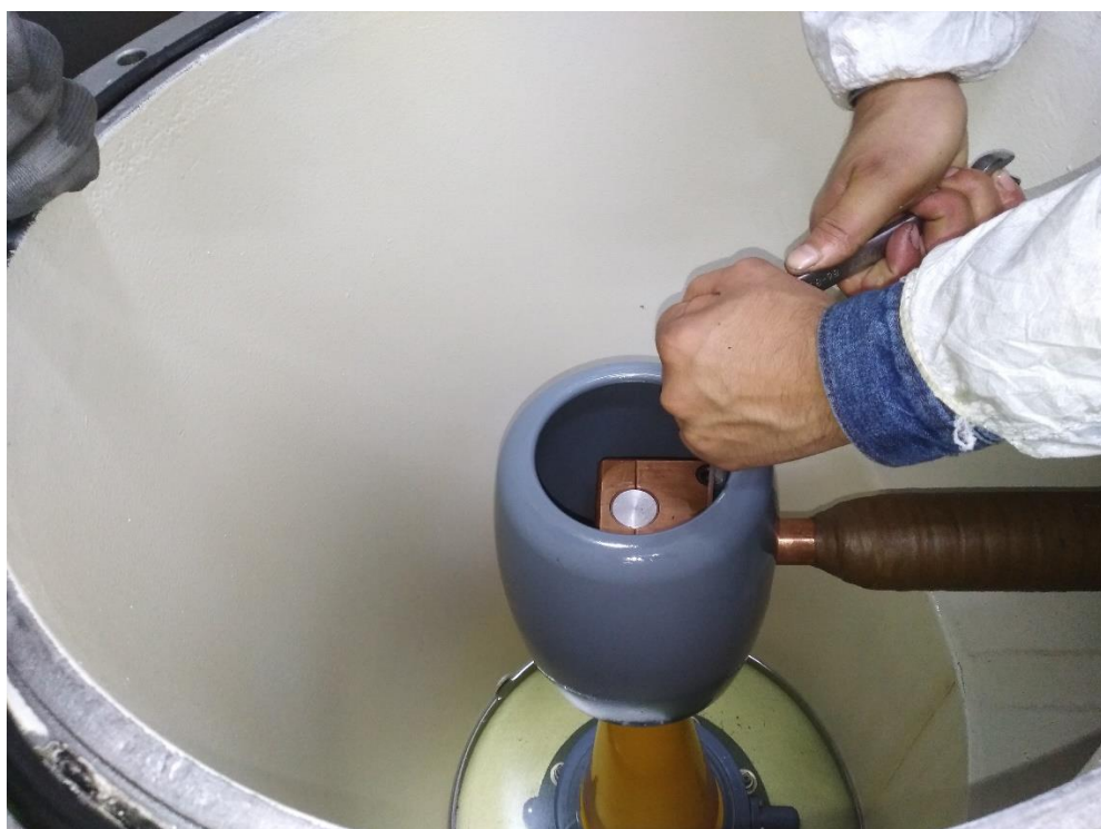
Foto 04: Conector del bushing de AT del transformador y la barra de conexión al conector del cable de AT
