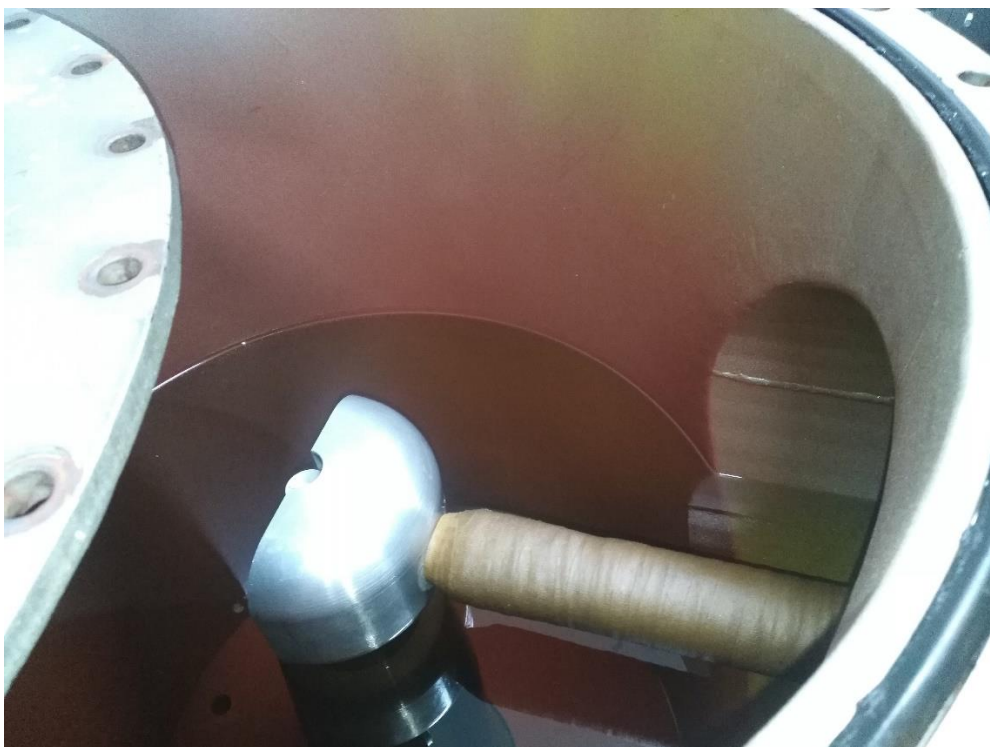
Foto 03: Conector y terminal del cable de AT con barra de conexión al bushing del transformador
