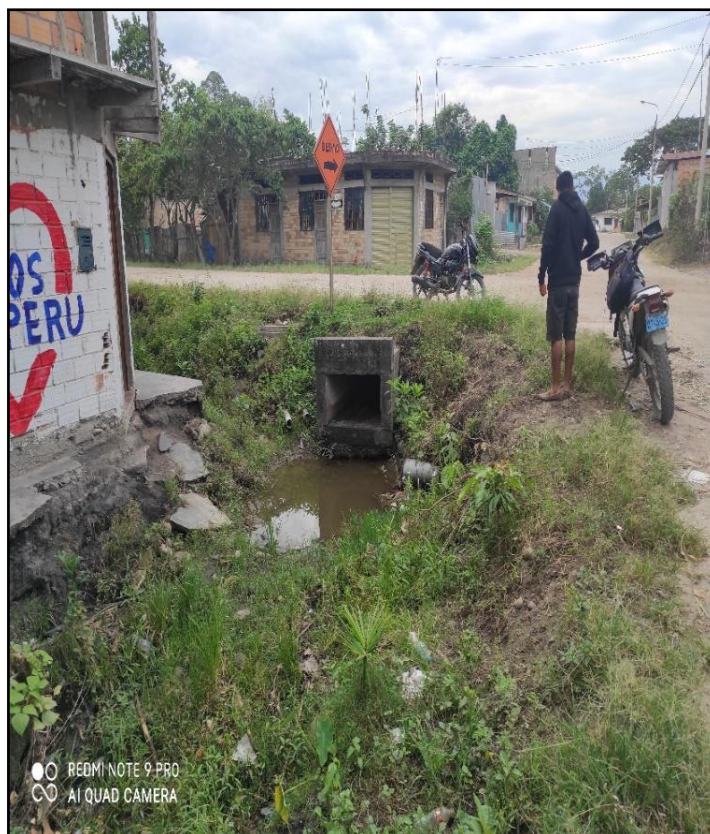
Jr. Bolognesi C 17 – En la siguiente imagen se puede demostrar los problemas de acumulación de aguas en las cunetas, provocando un problema de salubridad en el lugar.
