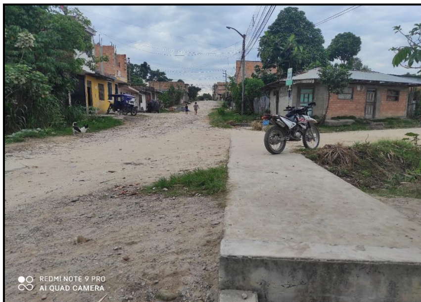
Jr. Bolognesi C 15 – En la presente imagen se observa el deterioro de la vía por la ausencia de un drenaje pluvial óptimo, haciendo que el agua de lluvia se estanque y provoque erosiones.
