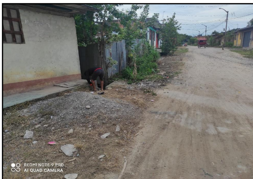
Jr. Bolognesi C 14 – Se puede demostrar en la presente imagen el mal estado en la que se encuentran la vía con drenaje deficiente, que no cumplen con las capacidades de entrega, causando que las precipitaciones afecten de manera directa al afirmado, generado deterioro en la vía.
