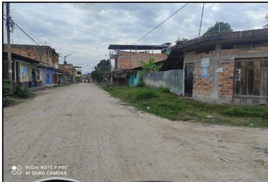
Jr. Bolognesi C 12 – Se puede apreciar el estado de la vía afirmada y se observa carencia de un drenaje pluvial que evite el problema de la erosión de los suelos.
