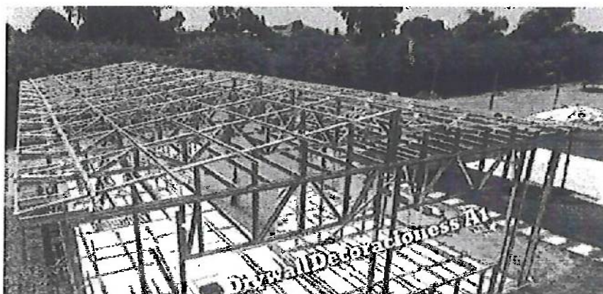
Imagen 05: estructura de parantes uso de estructura de drywall
