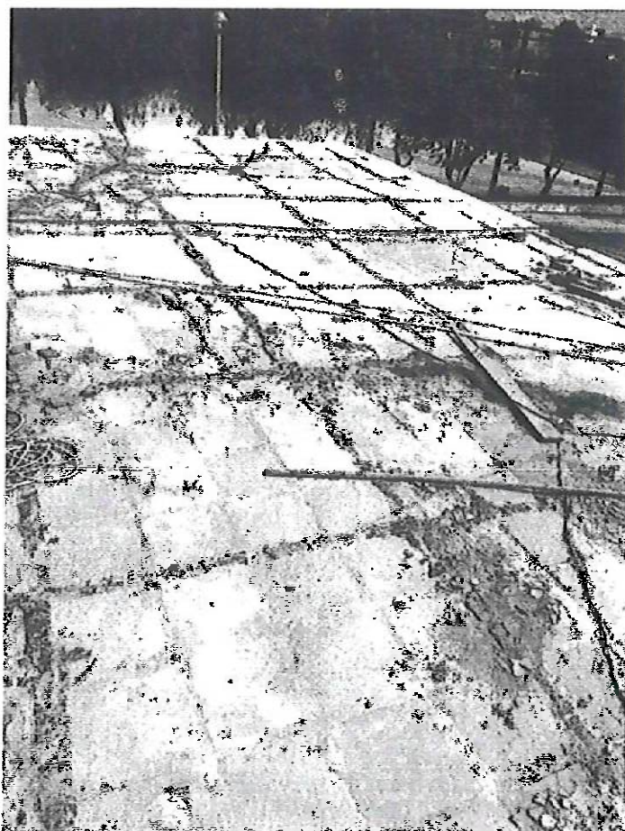
Imagen N°2: Mal estado del ladrillo pastelero en techo de bungalows, lo cual ocasiona filtraciones de las lluvias estacionales
