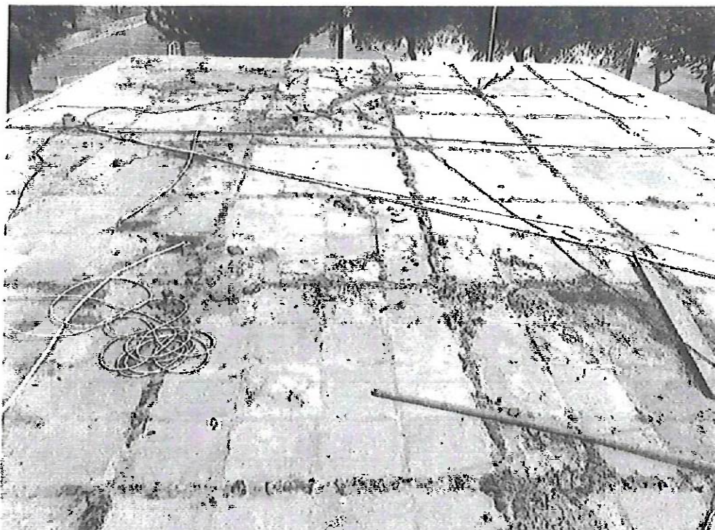
Imagen N°1: Mal estado del ladrillo pastelero en techo de bungalows, lo cual ocasiona filtraciones de las lluvias estacionales
