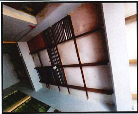
Fotografía N°05: cobertura liviana afectado por precipitaciones pluviales que han generado deterioro y oxido.
