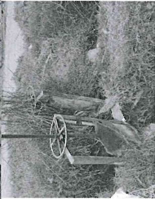
Foto 04: Compuertas en mal estado, que genera pérdidas de agua.
