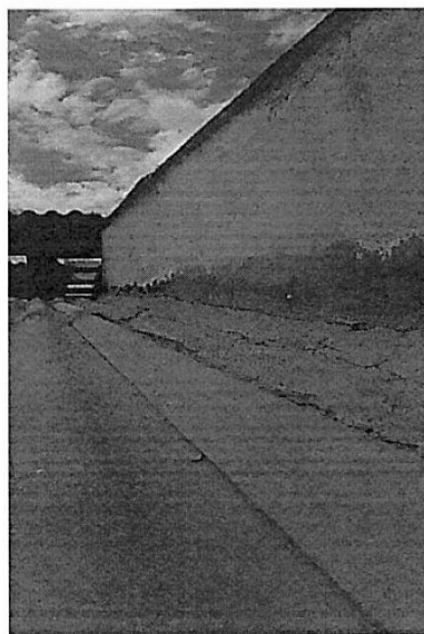
Foto 4: Zonas de filtración, es necesario cambiar la cobertura y sellar los encuentros entre paredes.
