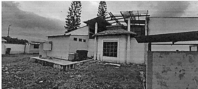
Parte posterior del establecimiento de salud donde la cobertura se encuentra en mal estado. Se proyectarán los voladizos a fin de evitar el escurrimiento sobre los muros.
