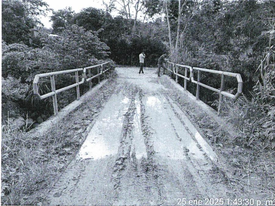
Figura 05: Puesto existente vista superior de la losa, empozada de agua de lluvias, no cuenta con un adecuado sistema de dren.
