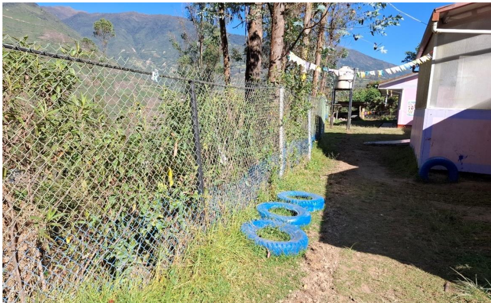
Figura 25: Vista del cerco perimétrico con mallas y marcos de metal
