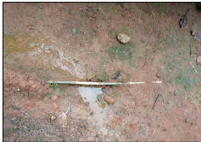
Se puede apreciar que no cuentan con cajas de registro
