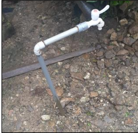
Se puede apreciar que no existen cajas de registro
