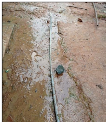
Se puede apreciar que no cuentan con conexiones domiciliarias apropiadas
