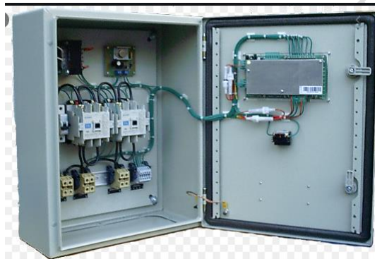
Fotografía referencial: tablero de transferencia automática
