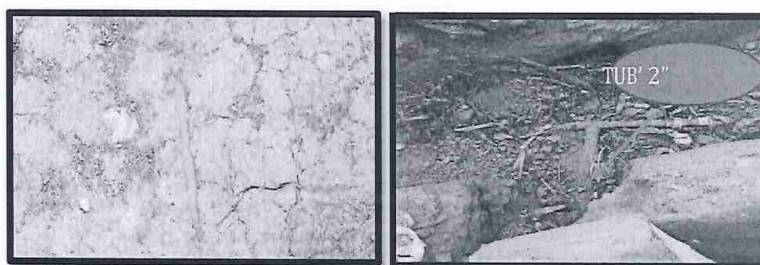
IMAGEN N° 03: RED DE DISTRIBUCION DE 2" EXPUESTA, PROPENSA A SER DAÑADA POR ANIMALES DE LA ZONA.
