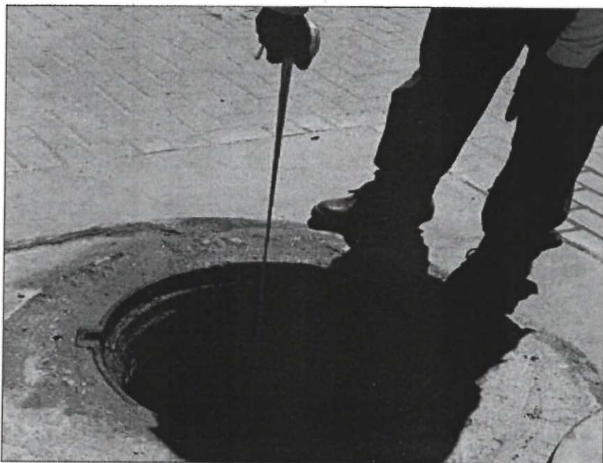
Ilustración 9: Buzones de concreto existentes, toma de profundidades.
