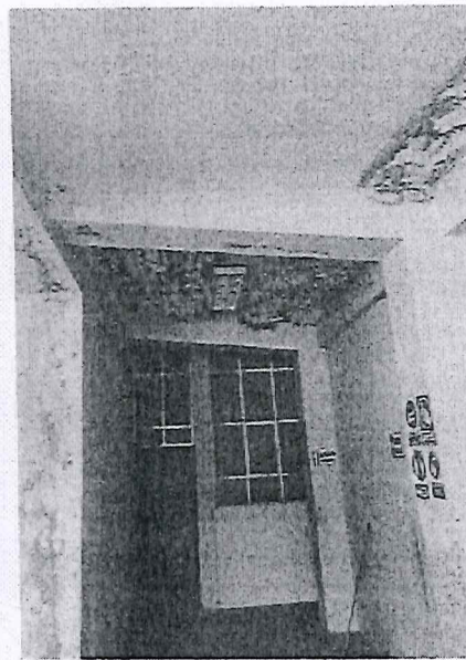
Zonas más afectada en el área del primer piso, denotándose filtraciones acumuladas en la losa
