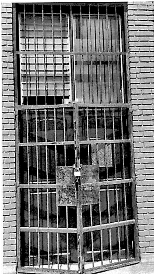
AULA 14 – VIDRIOS Y PROTECTORES EN MAL ESTADO
