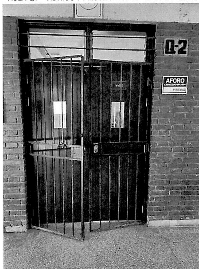
AULA Q2 – VIDRIOS Y PROTECTORES EN MAL ESTADO
