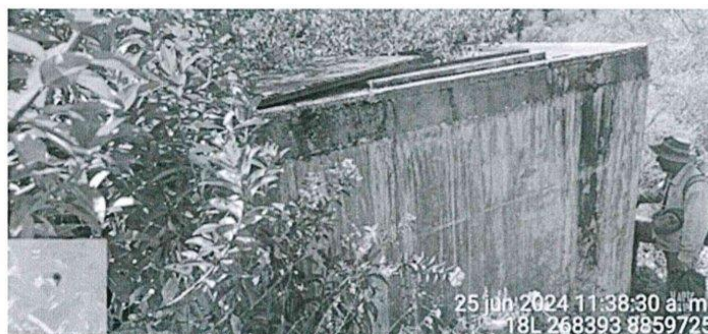
Fotografía: Cámara rompe presión N° 01.
