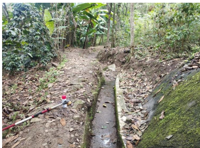
Foto N° 01: Se visualiza la tubería existente que empalma el acceso del caudal de la quebrada con el inicio del tramo del canal de riego la Ceiba.
