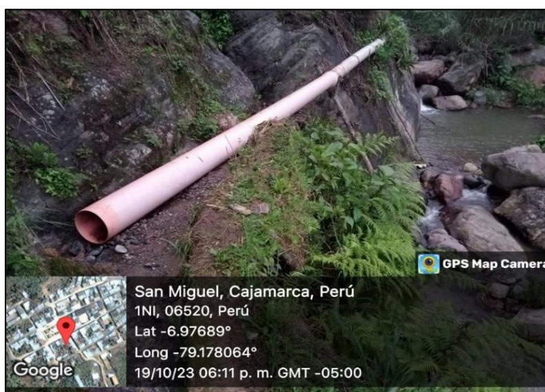
Foto N° 01: Se visualiza la tubería existente que empalma el acceso del caudal de la quebrada con el inicio del tramo del canal de riego la Ceiba.
