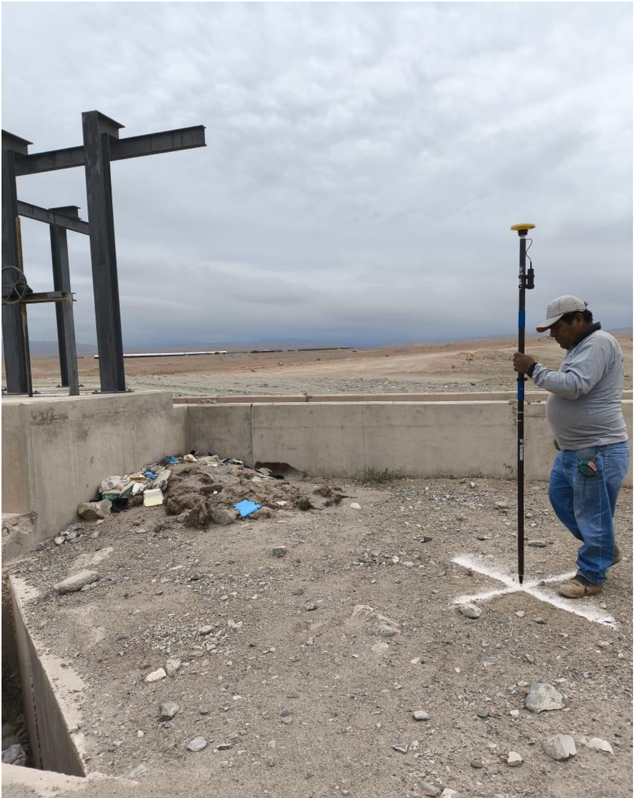
COLOCACION DE PUNTOS DE APOYO
