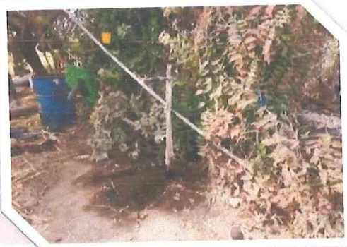
Imagen 07. Tubería PVC de la línea de conducción expuesta y en mal estado debido a su antigüedad y falta de mantenimiento
