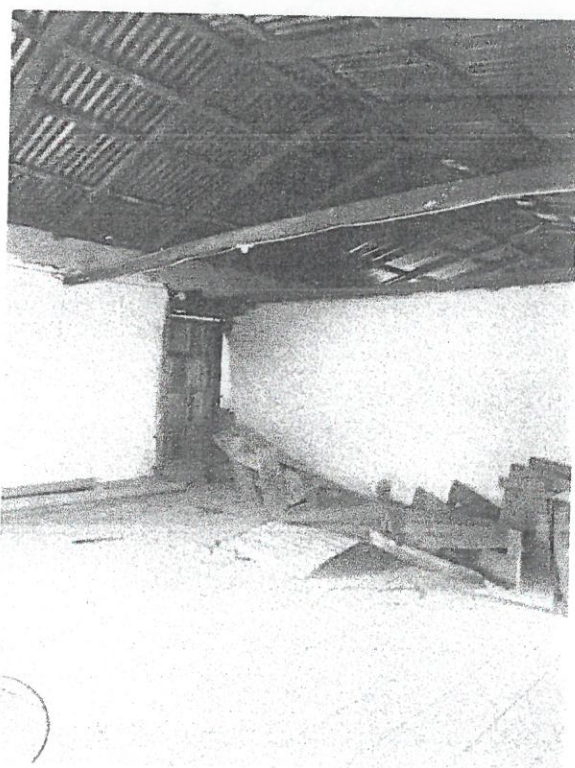
Foto N° 07: Aulas deterioradas sin cielo raso, acabados en mal estado y piso de madera.
