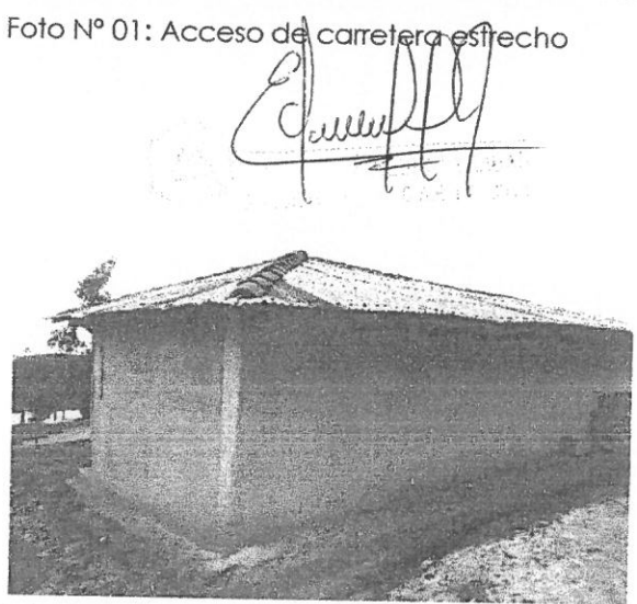
Foto N° 03: Muros deteriorados producto de la humedad y techo en mal estado
