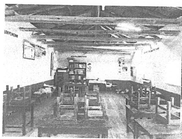
Foto N° 05: Aula con piso de madera y muros deteriorados, el techo en mal estado y sin iluminación
