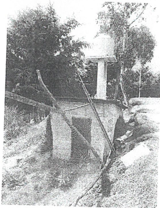
Foto N° 07: Letrina que funciona con pozo seco el cual se encuentra en malas condiciones
