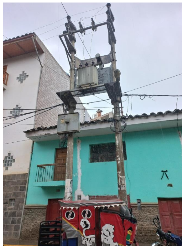
Subestaciones de distribución con fuga de aceite
