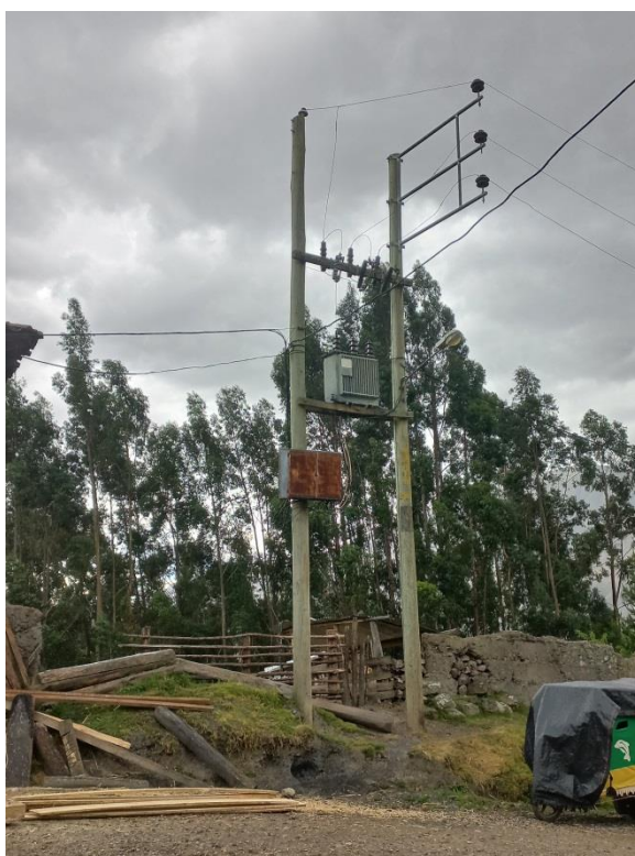
Subestación de distribución con seccionadores tipo cut out y tablero de distribución deteriorados
