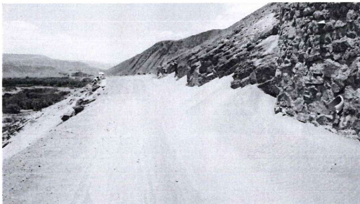
FOTO N° 12: KM. 23+700 TRAMO ARENADO REQUIERE LIMPIEZA DE CALZADA ELIMINAR MATERIAL QUE OBSTACULIZA TRANSITO VEHICULAR.
