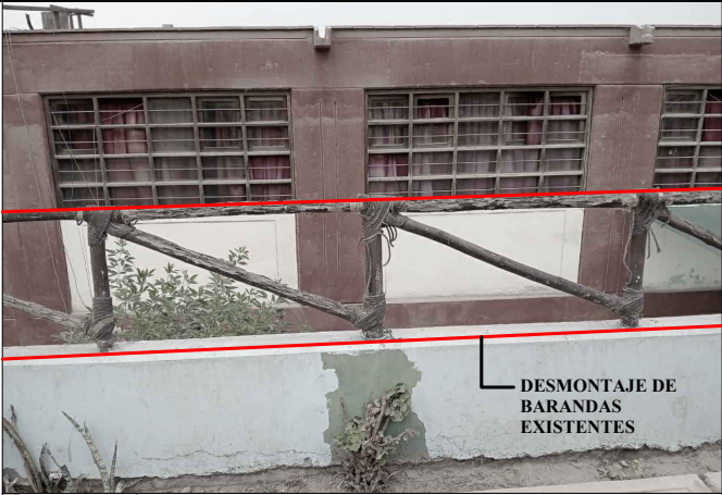
DESMONTAJE DE BARANDAS EXISTENTES
