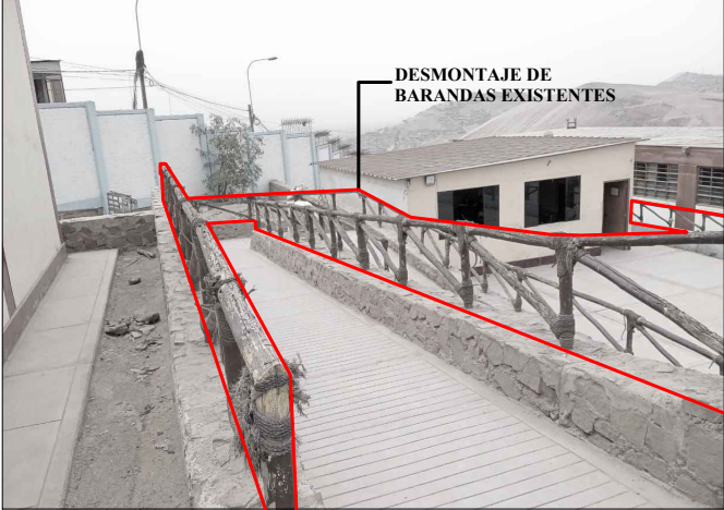
DESMONTAJE DE BARANDAS EXISTENTES
