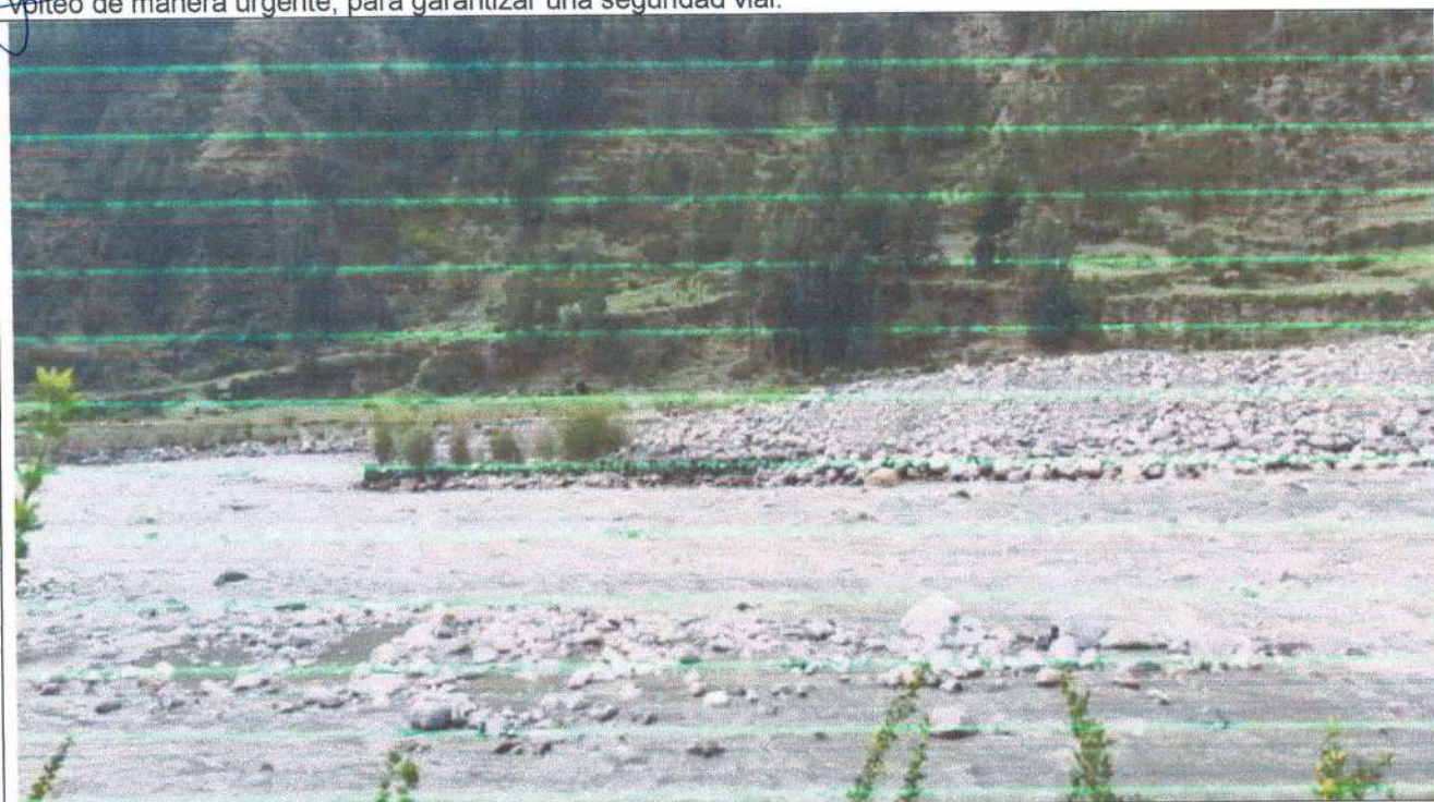
FOTOGRAFIA N° 03: se visualiza material tipo isla en el centro del río donde requiere realizar trabajos de limpieza y descolmatación con un ancho que pueda garantizar la fluidez del aumento del caudal de río mapacho margen izquierdo.
