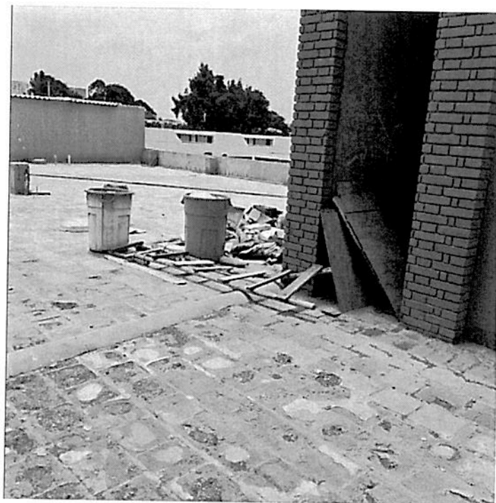
Foto N°05: Ladrillo pastelero en mal estado
