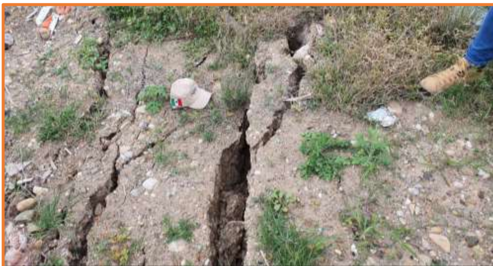
Imagen No. 03. Grietas de tensión sobre la plataforma realizada con material de cubierta
