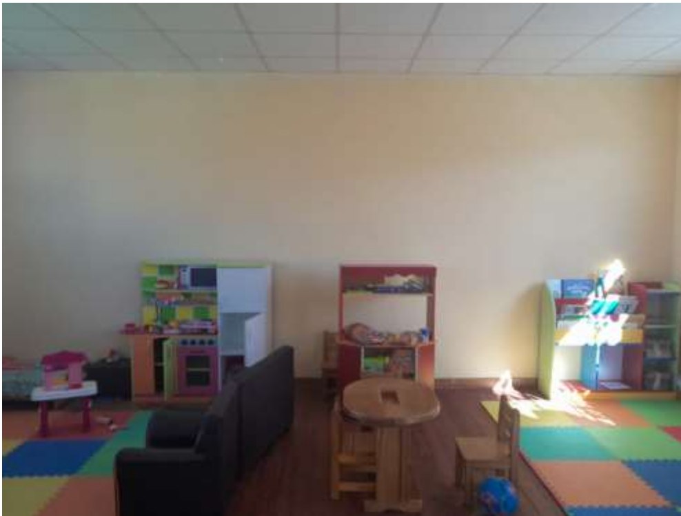
Fotografía 19: Vista del aula 02 del pabellón 1. Se aprecia cielo raso de baldosa en buen estado de Conservación, muro de albañilería confinada en buen estado de conservación.
