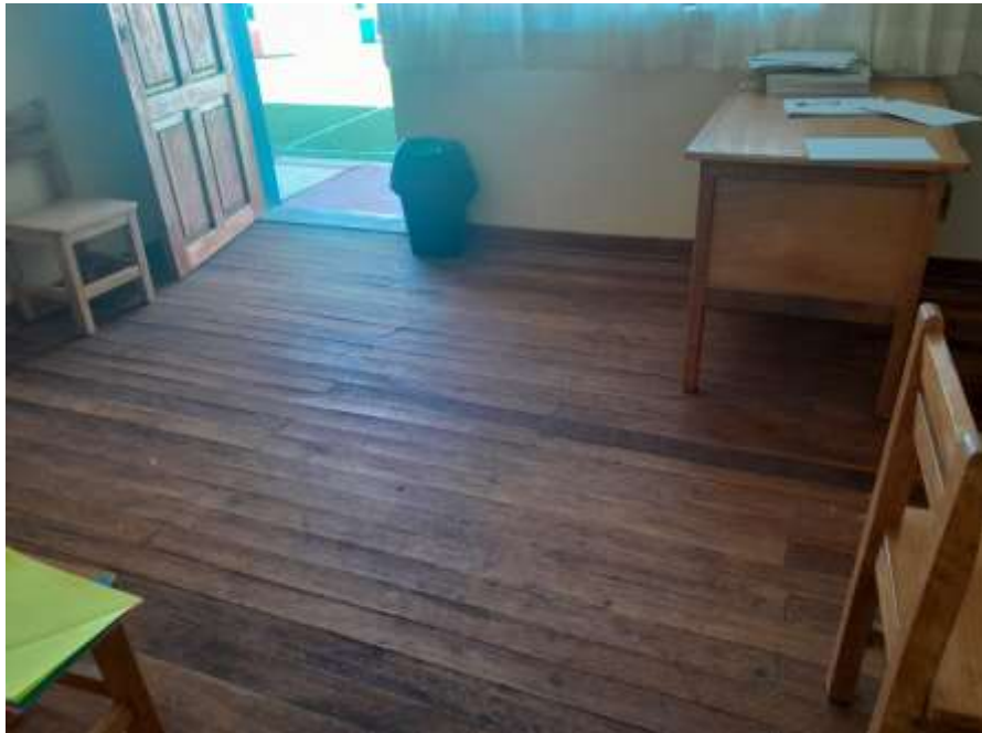
Fotografía 29: Vista interior de la dirección en el pabellón 1. Se aprecia el piso de madera en regular estado de conservación. Ambiente sin intervención con el acondicionamiento Térmico.
