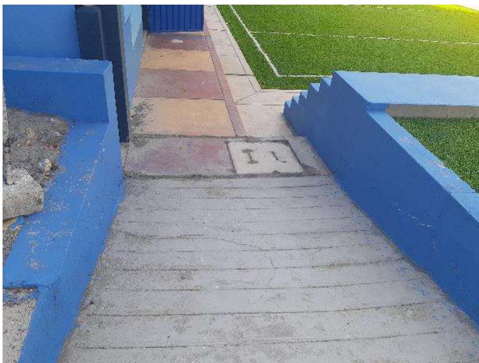
Fotografía 39: Vista de rampa de acceso, nótese la caja de registro de desagüe.
