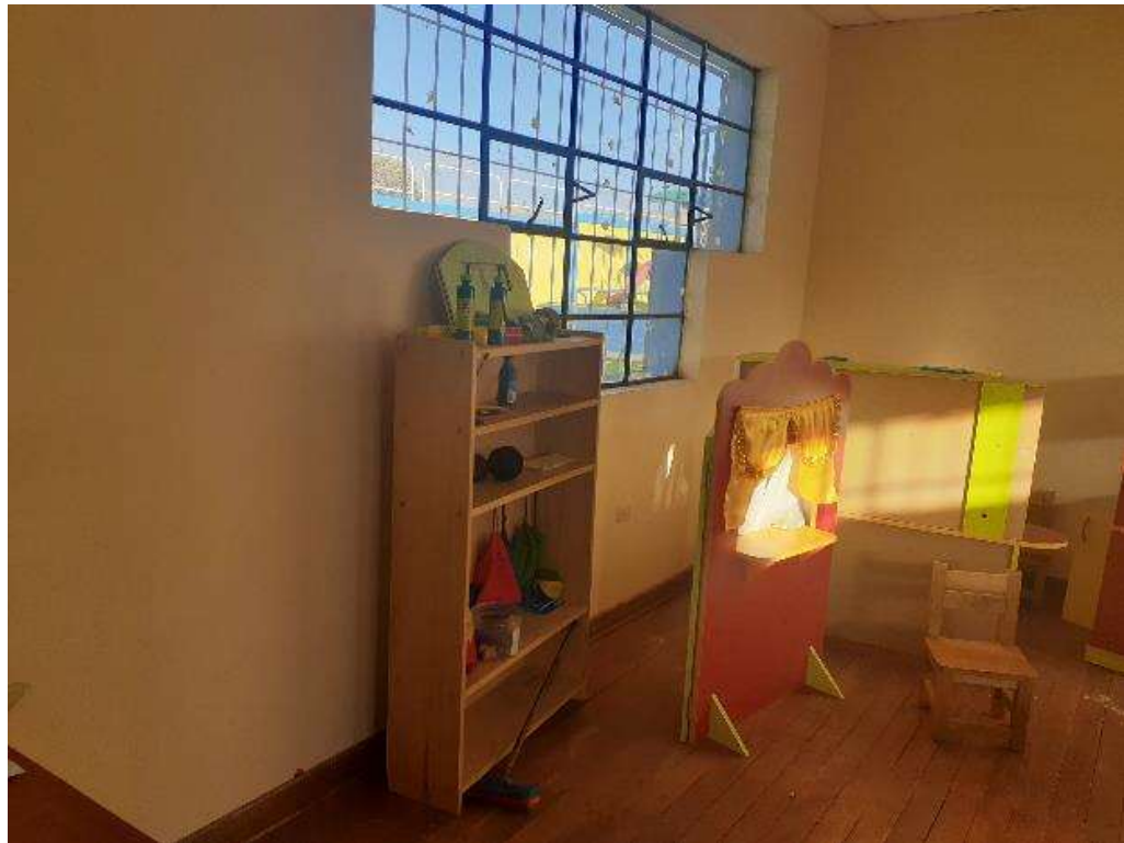
Fotografía 17: Vista interior del aula 01. Se aprecia el piso de madera en regular estado de conservación y Ventanas de marco de fierro en buen estado de conservación
