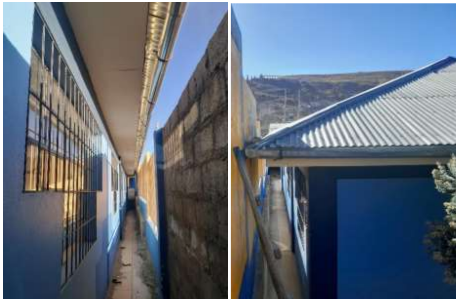
Fotografía 05, 06: Vista de la parte posterior del Pabellón 1. Muro de albañilería confinada en buen estado de conservación, cobertura de calamina metálica en buen estado de Conservación.
