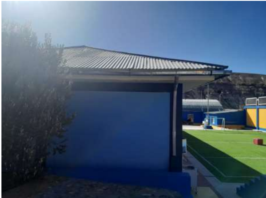
Fotografía 07: Vista lateral lado izquierdo entrando del Pabellón 1, se observa canaleta metálica y tubería de evacuación pluvial en regular estado de conservación.
