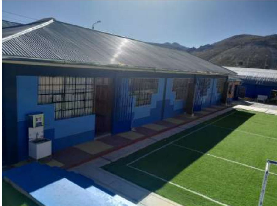
Fotografía 04: Vista en perspectiva del Pabellón 1 del nivel Inicial, nótese la infraestructura de albañilería confinada con cobertura liviana de calamina.
