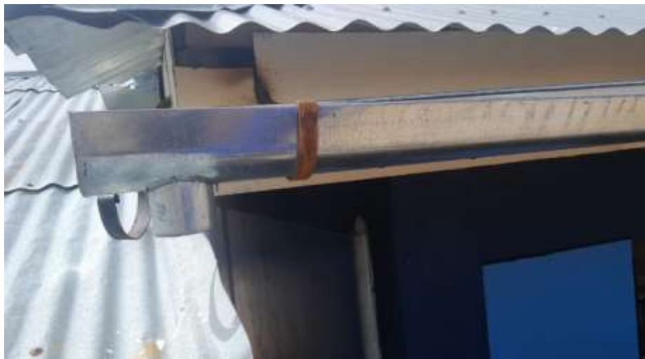
Fotografía 10, 11: Vista por la parte posterior lado lateral del Pabellón 1, la tubería de desagüe pluvial desconectada de la canaleta metálica existente.
