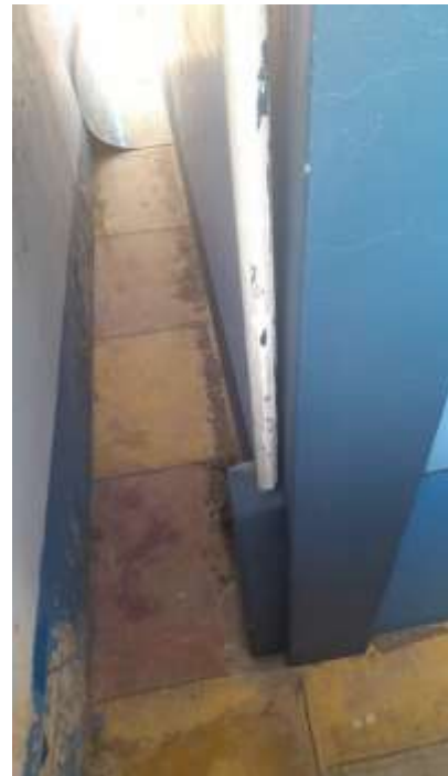
Fotografía 10, 11: Vista por la parte posterior lado lateral del Pabellón 1, la tubería de desagüe pluvial desconectada de la canaleta metálica existente.
