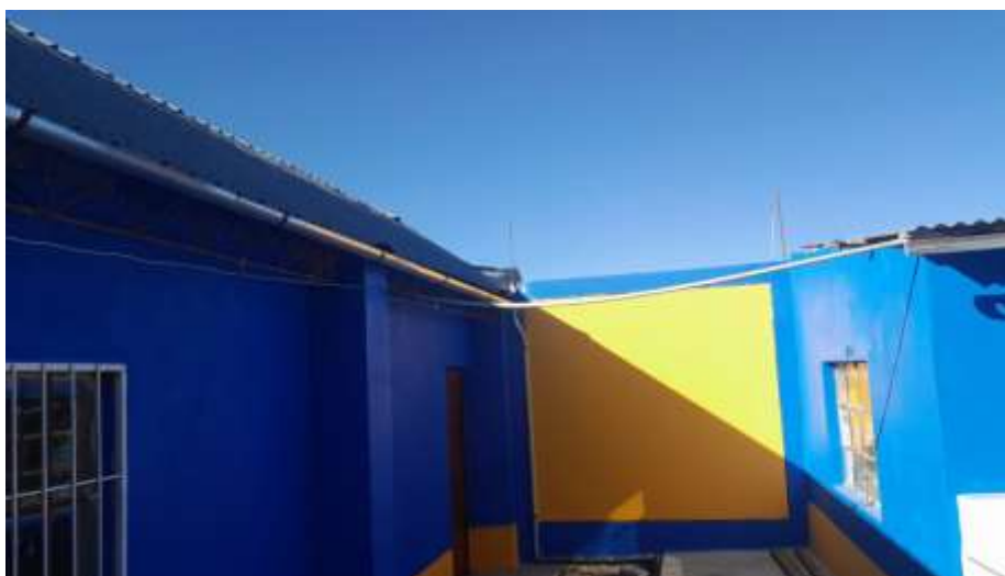
Fotografía 38: Vista del cableado eléctrico vía aérea que pasa del local comunal (lado derecho) al pabellón 4 (cocina).
