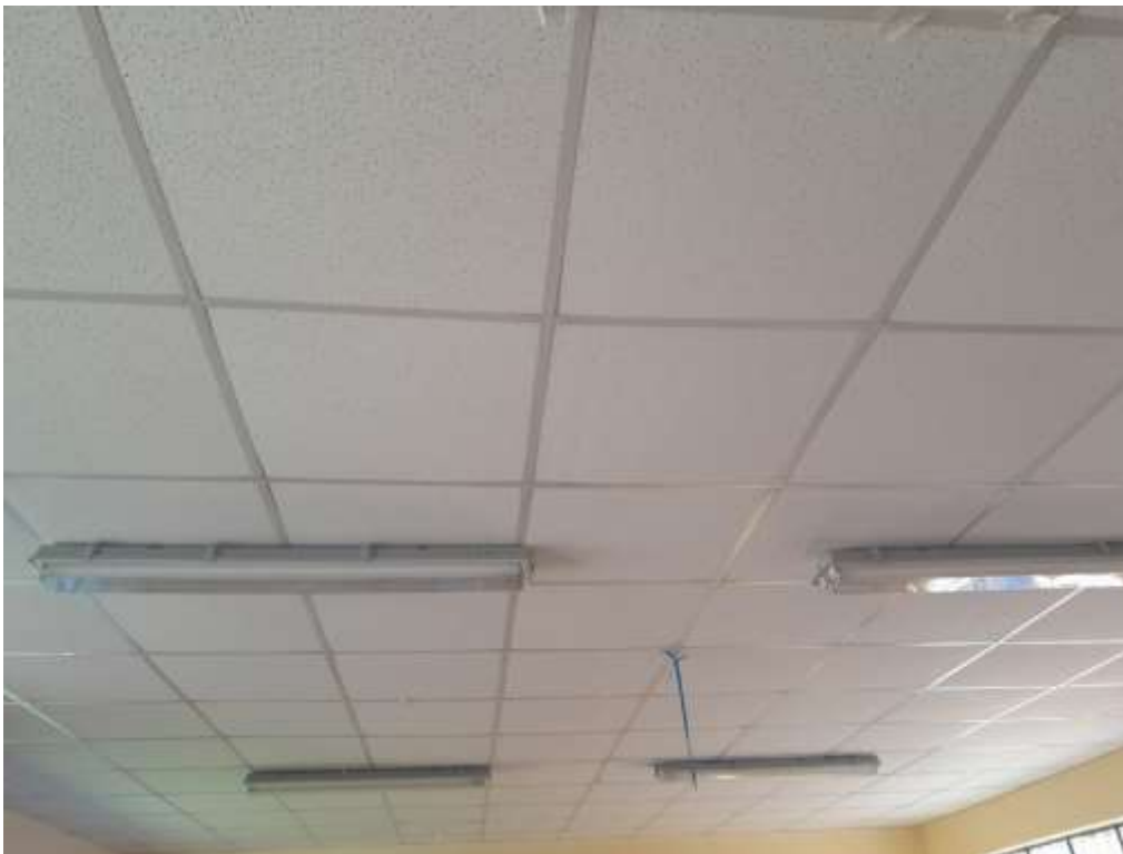
Fotografía 22: Vista del aula 02 del pabellón 1. Se aprecia el cielo raso de baldosas en buen estado de conservación.
