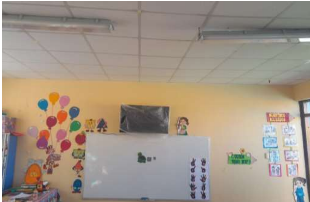
Fotografía 15: Vista interior del aula 01. Se aprecia cielo raso de baldosas en buen estado de conservación, luminarias fluorescentes con protección descolgándose en regular estado de conservación
