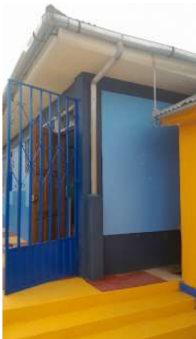
Fotografía 07: Vista lateral lado izquierdo entrando del Pabellón 1, se observa canaleta metálica y tubería de evacuación pluvial en regular estado de conservación.
