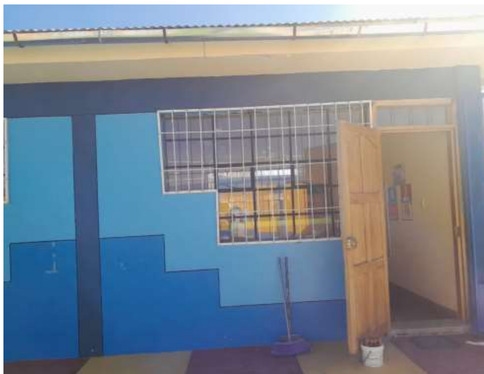
Fotografía 14: Vista exterior del aula del Pabellón 1, se observa puertas de madera y rejas metálicas en buen estado de conservación, ventanas de marco de fierro+rejas de fierro como protección en buen estado de conservación y protección falso cielo raso de fibrocemento en regular estado de conservación.
