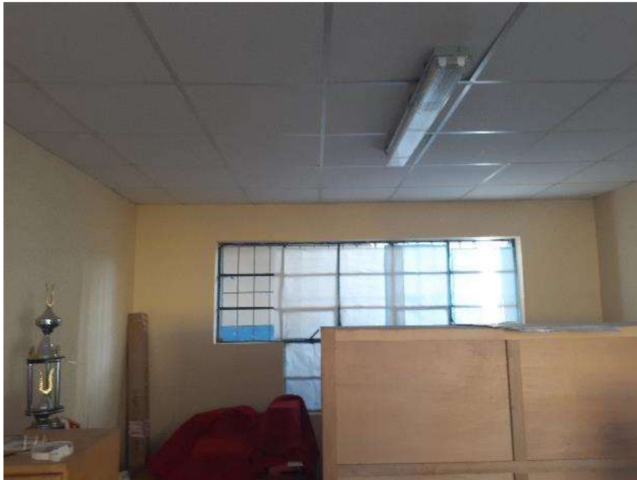
Fotografía 27: Vista interior de la dirección en el pabellón 1. Se aprecia el cielo raso a base de Baldosas y luminarias de fluorescente con protector en regular estado de conservación. Ambiente sin intervención con el acondicionamiento térmico.
