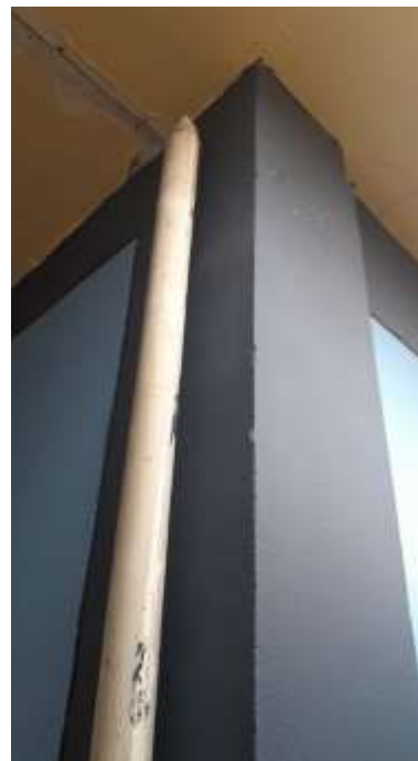
Fotografía 07: Vista lateral lado izquierdo entrando del Pabellón 1, se observa canaleta metálica y tubería de evacuación pluvial en regular estado de conservación.
