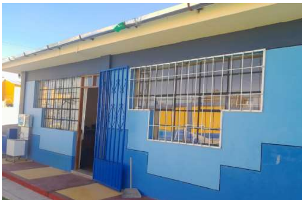
Fotografía 13: Vista exterior de la dirección del Pabellón 1, se observa puertas de madera y rejas metálicas en buen estado de conservación, ventanas de marco de fierro + rejas de fierro como protección en buen estado de conservación y protección falso cielo raso de fibrocemento en Regular estado de conservación.
