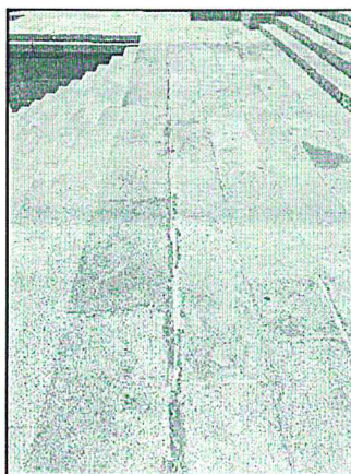
Figura 8 a 13: Se observa el deterioro de las escalinatas en el sector "B", mostrándose fisuras en los morteros de junta (e inclusive ausencia del mismo), manchas negruzcas, coloración en superficie, manchas de humedad, manchas blanquecinas y amarillentas, acumulación de sales, bases de pilares con manchas por saturación, capilaridad y depósitos de sales.
